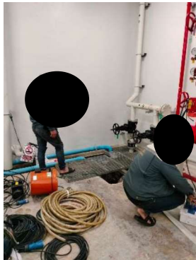
ภาพที่ 2-18 ตรวจสอบการรั่วไหลของถังสำรองน้ำ
