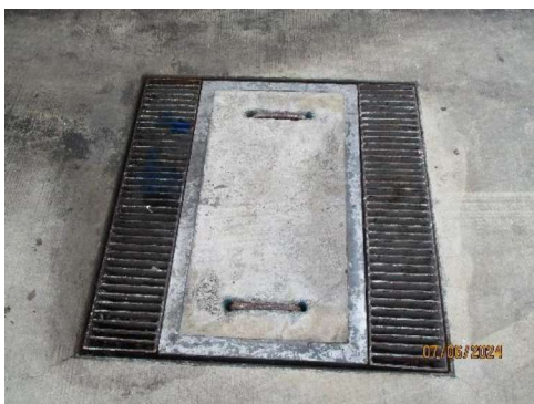
ภาพที่ 2-22 ตะแกรงดักขยะที่บ่อก่อนระบายออกสู่สาธารณะ
