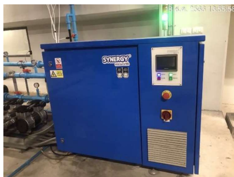
ภาพที่ 2-33 ระบบปรับอากาศแบบศูนย์รวม (Water Cooled Chiller) และเครื่องมือฆ่าเชื้อโรคน้ำที่ใช้ในการหล่อเย็น
