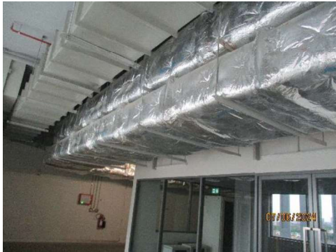
ภาพที่ 2-20 ระบบระบายอากาศในห้องบำบัดน้ำเสีย
