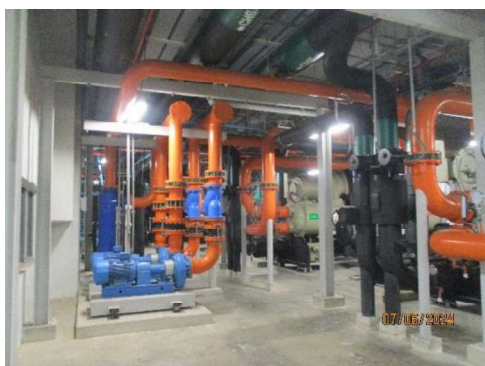
ภาพที่ 2-33 ระบบปรับอากาศแบบศูนย์รวม (Water Cooled Chiller) และเครื่องมือฆ่าเชื้อโรคน้ำที่ใช้ในการหล่อเย็น
