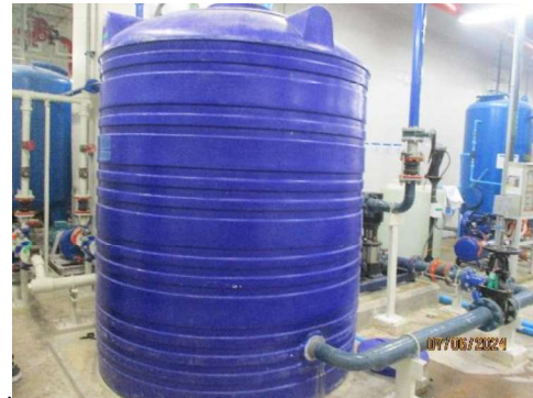
ภาพที่ 2-15 ถังสำรองน้ำใช้ และน้ำสำรองดับเพลิง
