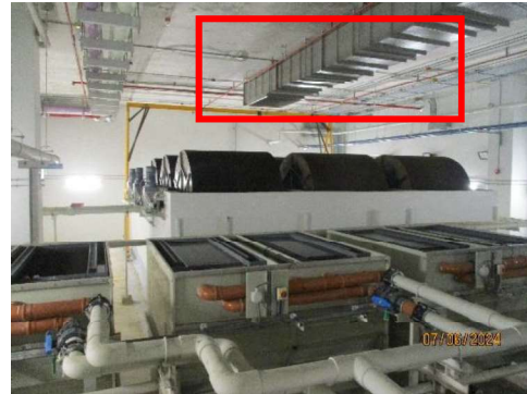
ภาพที่ 2-20 ระบบระบายอากาศในห้องบำบัดน้ำเสีย
